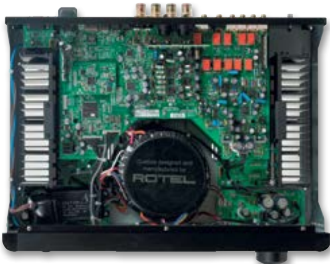
Rotel RA-1572 внутри
