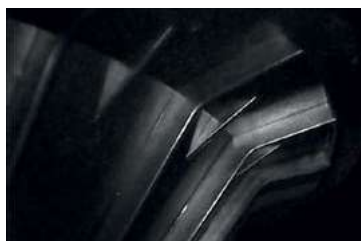
Камера-интраскоп позволила разглядеть детали траверсы: ребра жесткости и косынки-контрфорсы на изгибах,...
