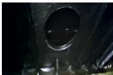
...а также вентиляционные отверстия в траверсе
